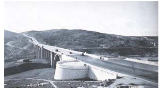
Fotografia 4 – Auto – estrada Lisboa/Cascais e Viaduto Duarte Pacheco – Anos 50
